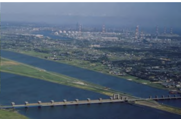
利根川河口堰
