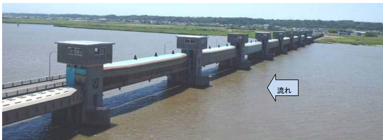
全門全開中の利根川河口堰 (平成26年6月13日撮影)
