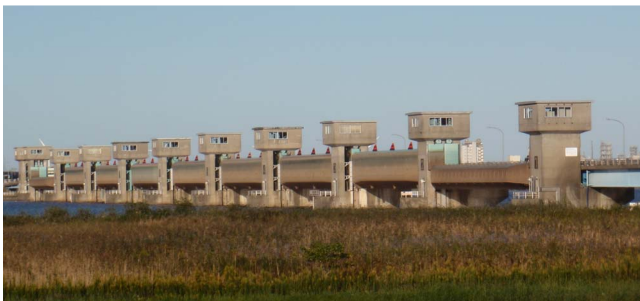
全門全開中の利根川河口堰 (平成26年10月7日撮影)
