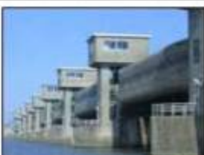
河口堰制水門
