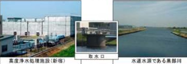
高度浄水処理施設(新宿) 取水口 水道水源である黒部川
