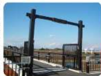
岡堰中の島橋
