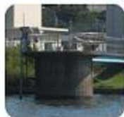
鎌子市水道浄取水口
