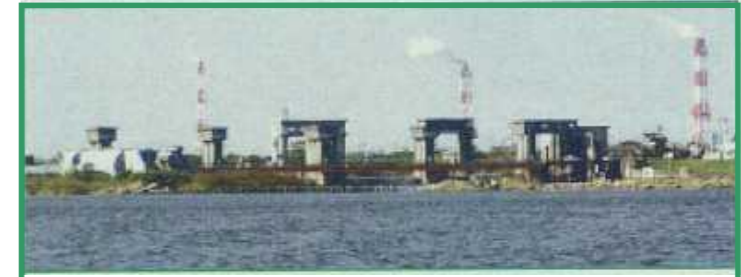
④常陸川閘門
