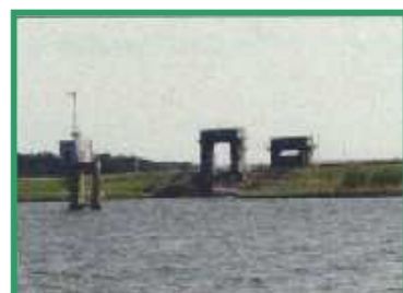
③阿玉川閘門
