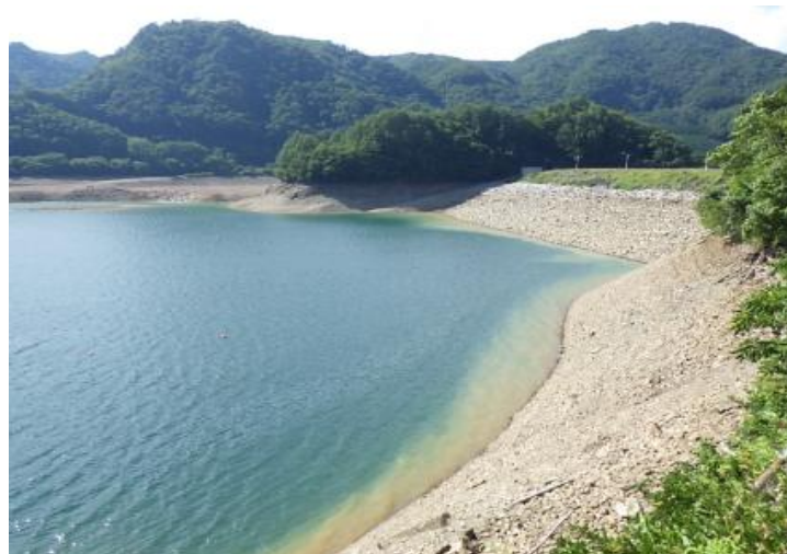
上流側からダム堤体を望む
