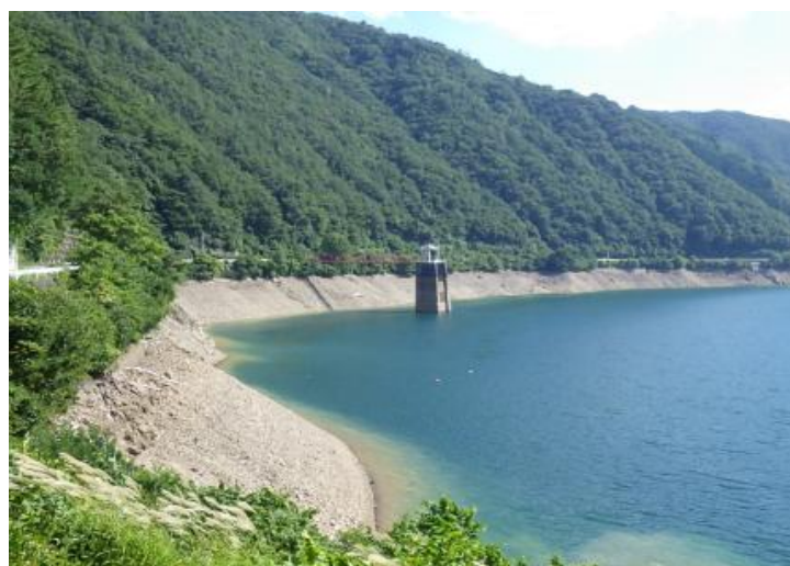
ダム堤体側から取水塔を望む
