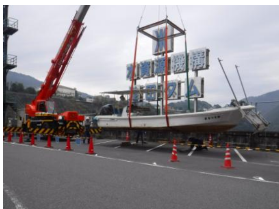
作業船 (第5つるぎ)昇降作業
