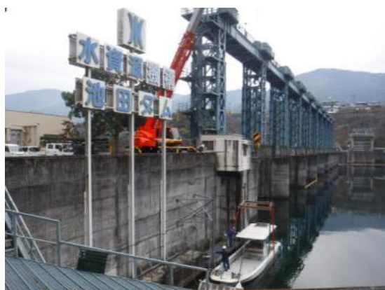
作業船 (第5つるぎ)昇降作業
