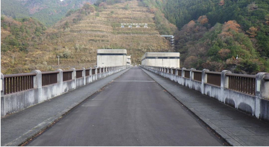
写真3 堤頂道路 全景
