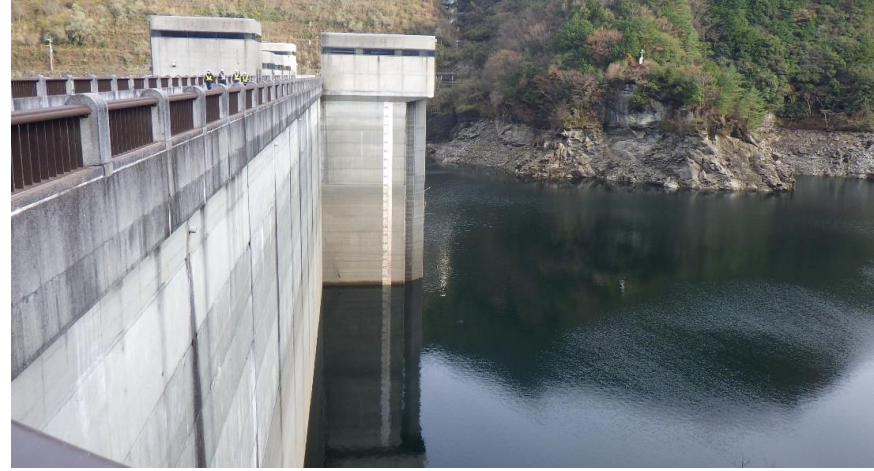
写真2 堤頂道路から貯水池(EL423の場合)
