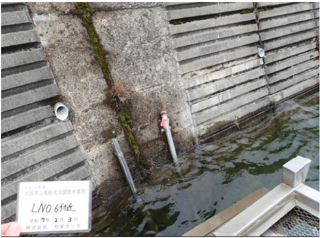
水位計設置例(水上部)
