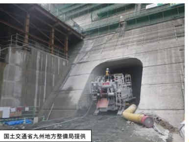
掘削機 (ドリルジャンボ) により堤体を下流側 から掘削し、3本の放流管を増設します。
