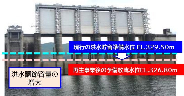
クレストゲートと洪水貯留準備水位の関係
