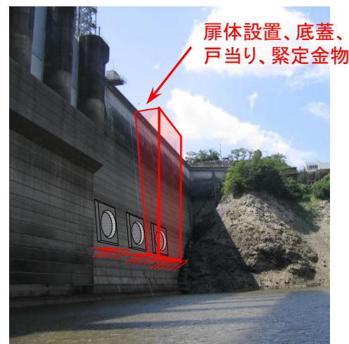
上流仮締切工事
