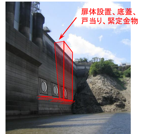
上流仮締切工事
