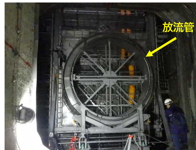
堤体削孔部に設置した放流管の一部
