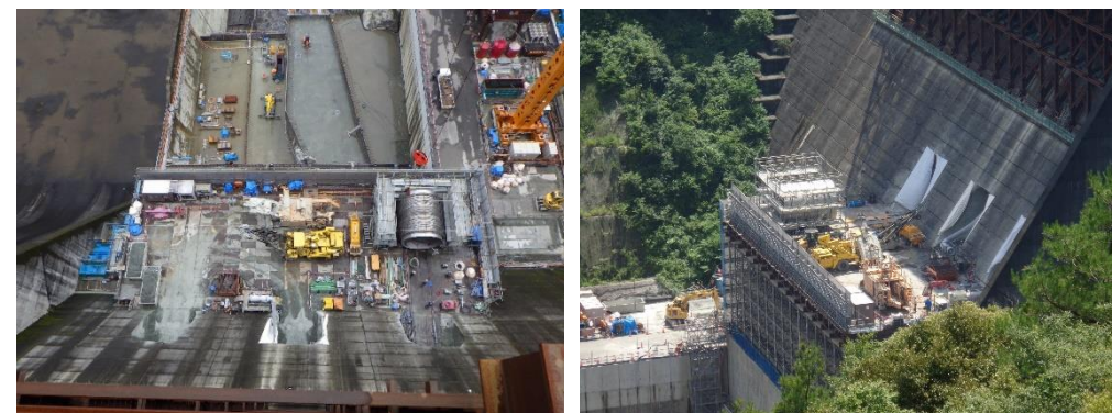
放流管設置中(令和7年6月)
