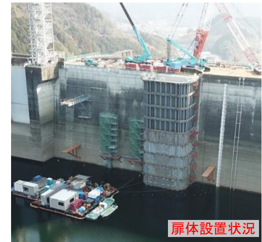
上流仮締切工事
