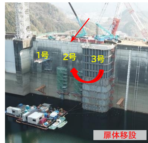
上流仮締切工事
