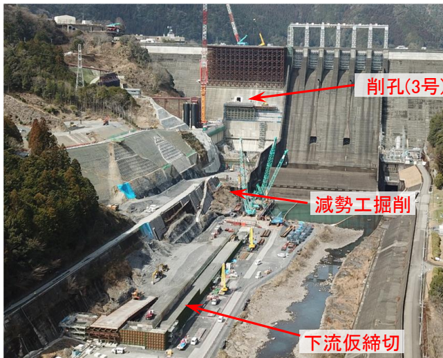
増設洪水吐き工事
