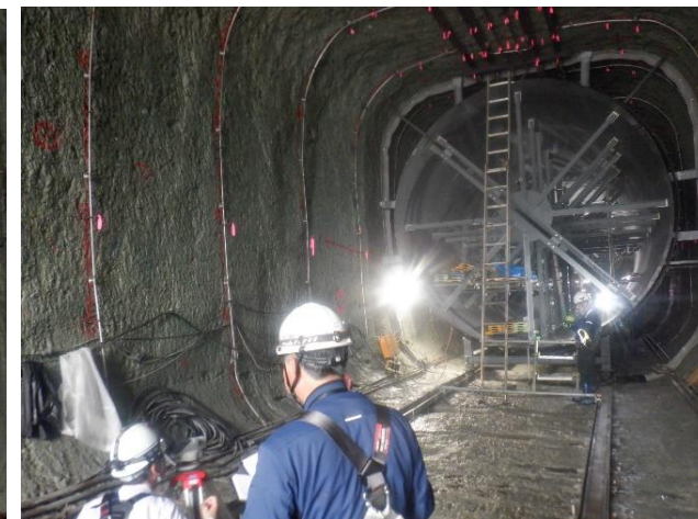
堤体削孔部に設置した放流管の一部 (堤体削孔の下流側から見た写真)
