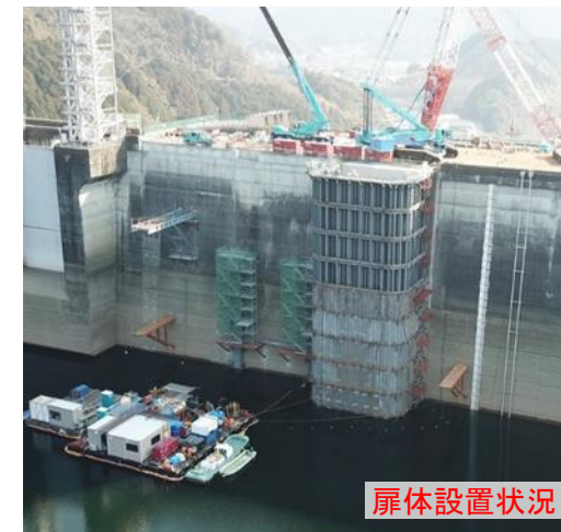
上流仮締切工事
