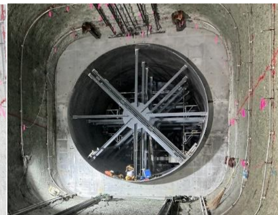
堤体削孔部に設置した放流管の一部 (堤体削孔の下流側から見た写真)
