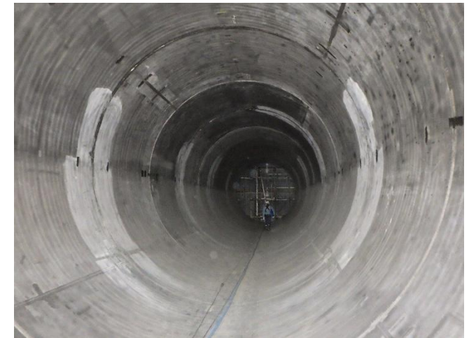
令和7年10月 3号放流管内 (スパイダー撤去後の写真)
