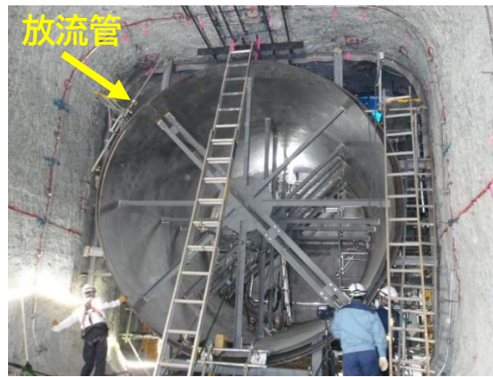
堤体削孔部に設置した放流管の一部 左:放流管据付 右:放流管の周りにコンクリート充填後 (堤体削孔の下流側から見た写真)
