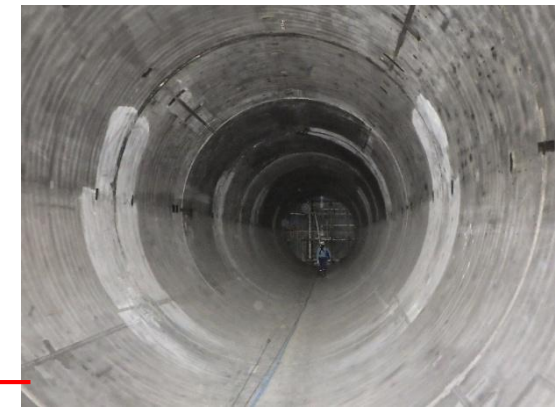
令和7年10月 3号放流管内 (スパイダー撤去後の写真)
