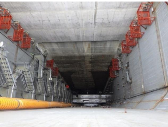
上流仮締切内の様子 (上から見た写真)
