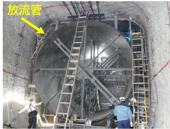
堤体削孔部に設置した放流管の一部 左:放流管据付 右:放流管の周りにコンクリート充填後 (堤体削孔の下流側から見た写真)
