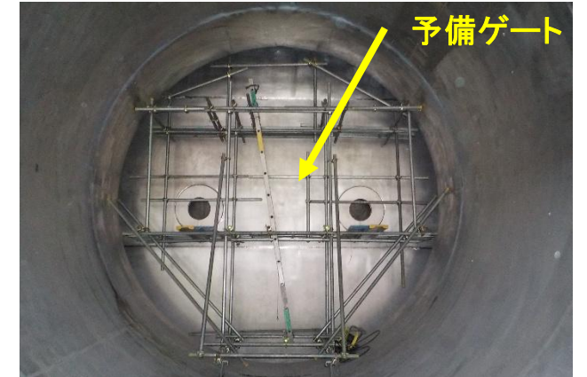
3号放流管下流側(放流管内)から見た予備ゲート
