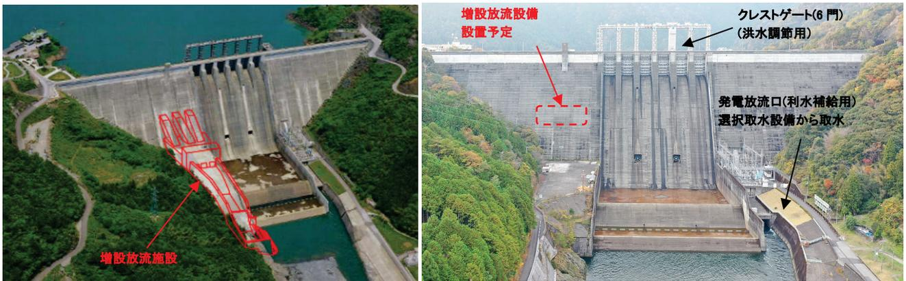
図 1-5 増設放流施設のイメージ (左) と既設放流設備と増設放流設備(イメージ) の配置図(右)
