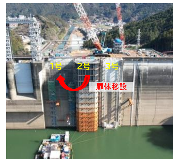
上流仮締切工事
