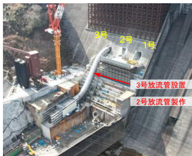
増設放流設備工事
