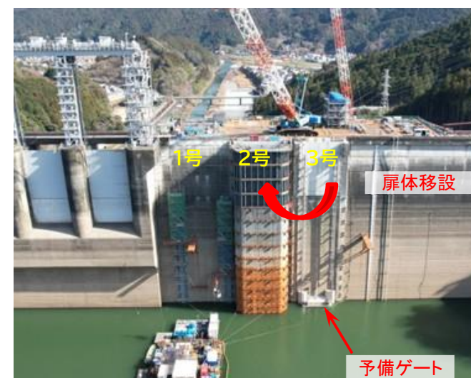
上流仮締切工事
