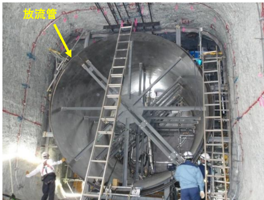
堤体削孔部に設置した放流管の一部 左:放流管据付 右:放流管の周りにコンクリート充填後 (堤体削孔3号の下流側内部から見た写真)
