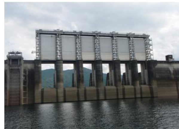
現行の放流ゲート (写真は点検のためゲートを開けた状態)
