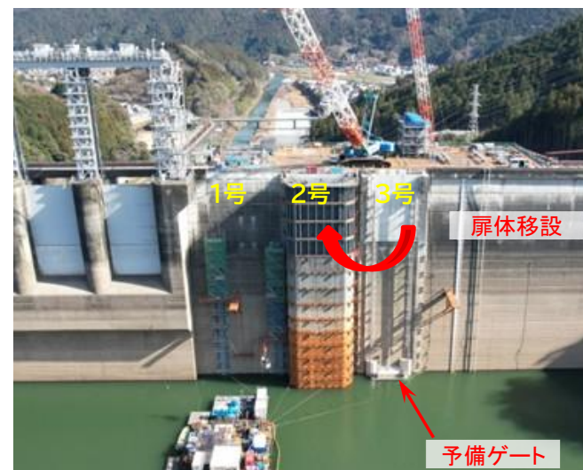
上流仮締切工事
