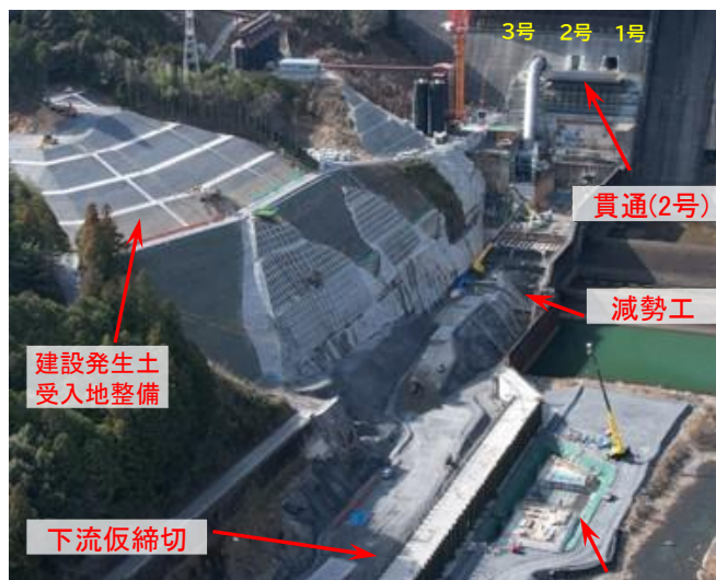
増設洪水吐き工事
