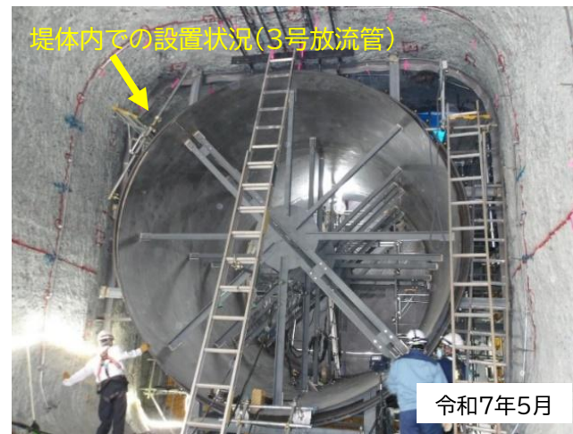
堤体削孔部に設置した3号放流管の一部 (堤体削孔の下流側から見た写真)
