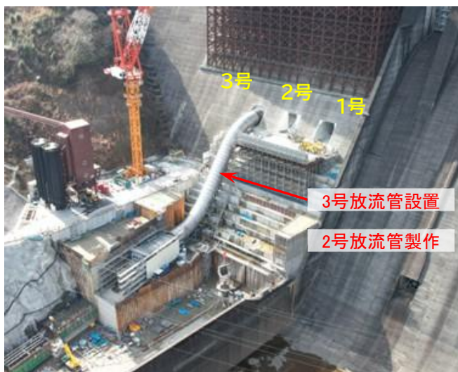
増設放流設備工事
