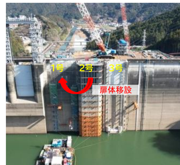
上流仮締切工事
