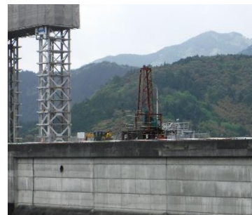
観測設備設置(プラムライン) 観測孔削孔工事
