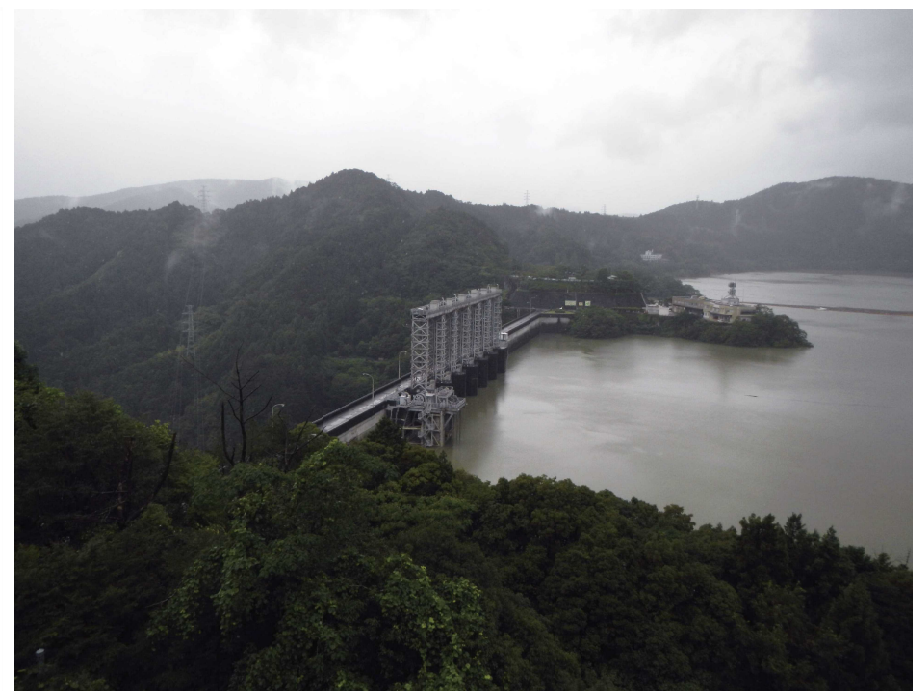
▲洪水調節後の早明浦ダム（平成30年7月8日撮影）
