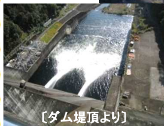
【利水放流管からの放流状況】
