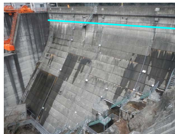
写真1 堤体下流面漏水状況 (左岸側BL2~5)
