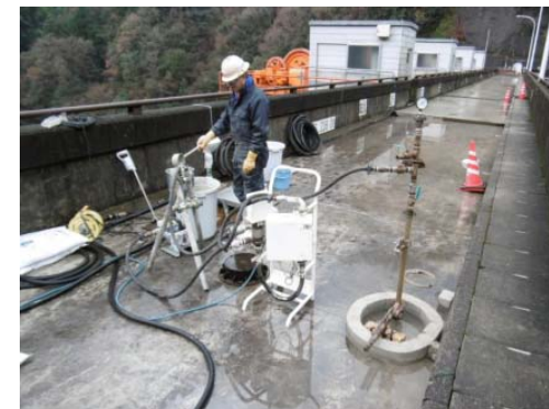
超微粒子セメント注入状況
