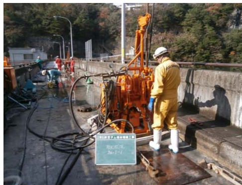
機械ボーリング削孔状況
