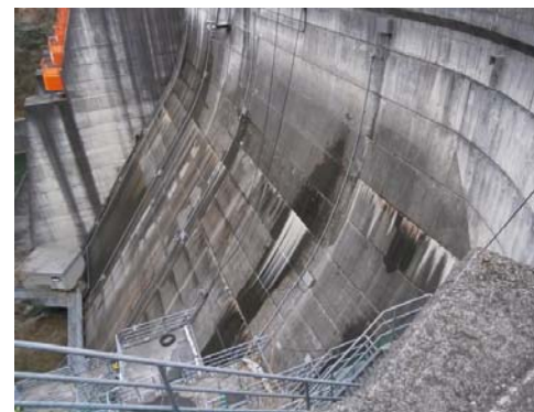
3BL EL227.00m水平打継面注入時リーク状況
