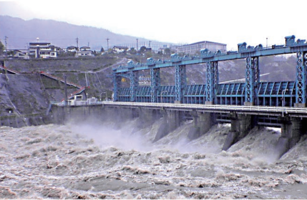
池田ダム 平成16年10月20日 放流量：9,000m³/s
