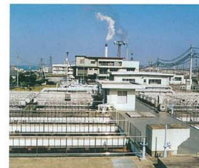
中田井浄水場(四国中央市水道局施設)
