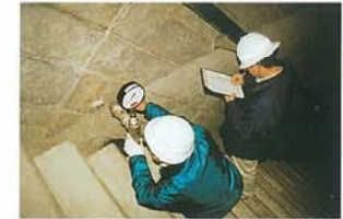
堤体観測 (揚圧力)
