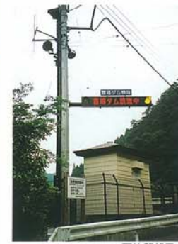
下流警報局舎
