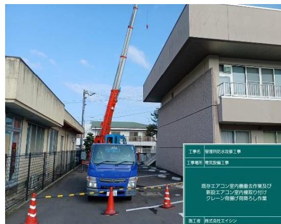
クレーン作業を休日に施工
