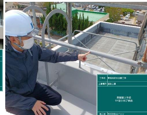
屋上屋根塗装工事完了
