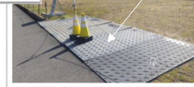
プラシキによる養生
