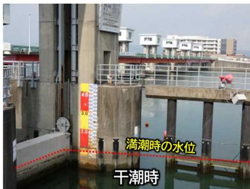
河口堰は、堰の上流側に貯留した川の水をいつも安定的に取水し利用できるよう、河川の流量と毎日生じる潮汐の変化に応じ、海水が遡上しないように水門（ゲート）を稼働させ、海水の浸入を常時監視しています。
