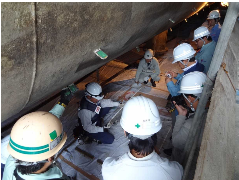
ゲート前面（川側）
