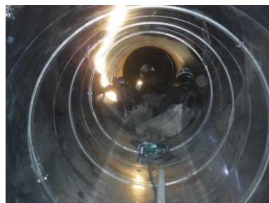
③SUS巻管据付 (溶接)
