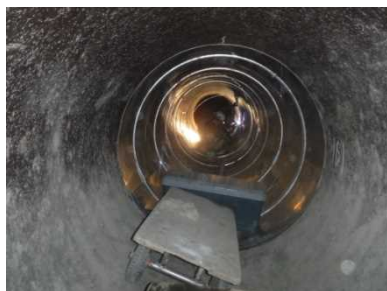
③SUS巻管据付 (溶接)
