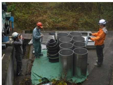
①補修材料 (SUS巻管)
