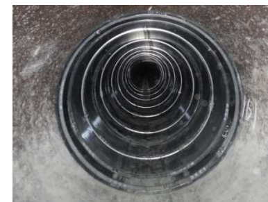
③SUS巻管据付 (完了)
